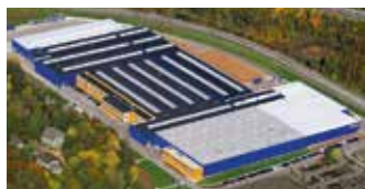
Hörmann KG Eckelhausen, Allemagne
